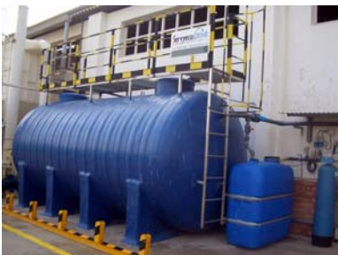
Depuradora de aguas residuales urbanas. Caudal 16 m 3 /día
