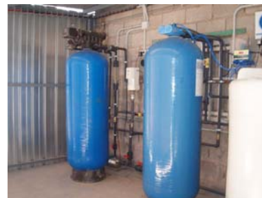
Depuradora de aguas residuales urbanas. Caudal 16 m 3 /día
